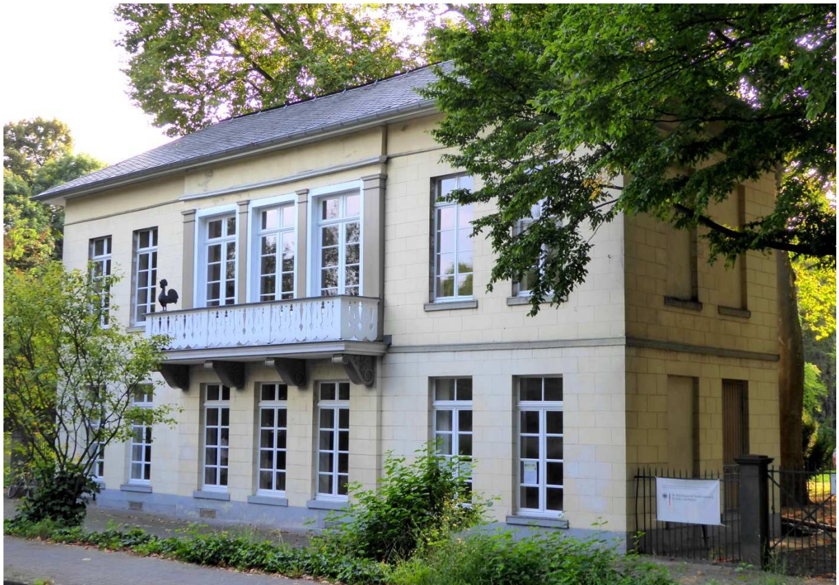
Köln-Müngersdorf, Belvederestr. 147, Bahnhof Belvedere, Straßenfront Ostseite, Blick von NO.
